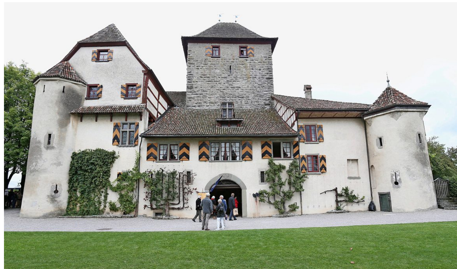
Das Schloss Hegi muss dringend saniert werden. Mitte 2022 starten die Bauarbeiten. Foto: Patrick Gutenberg
